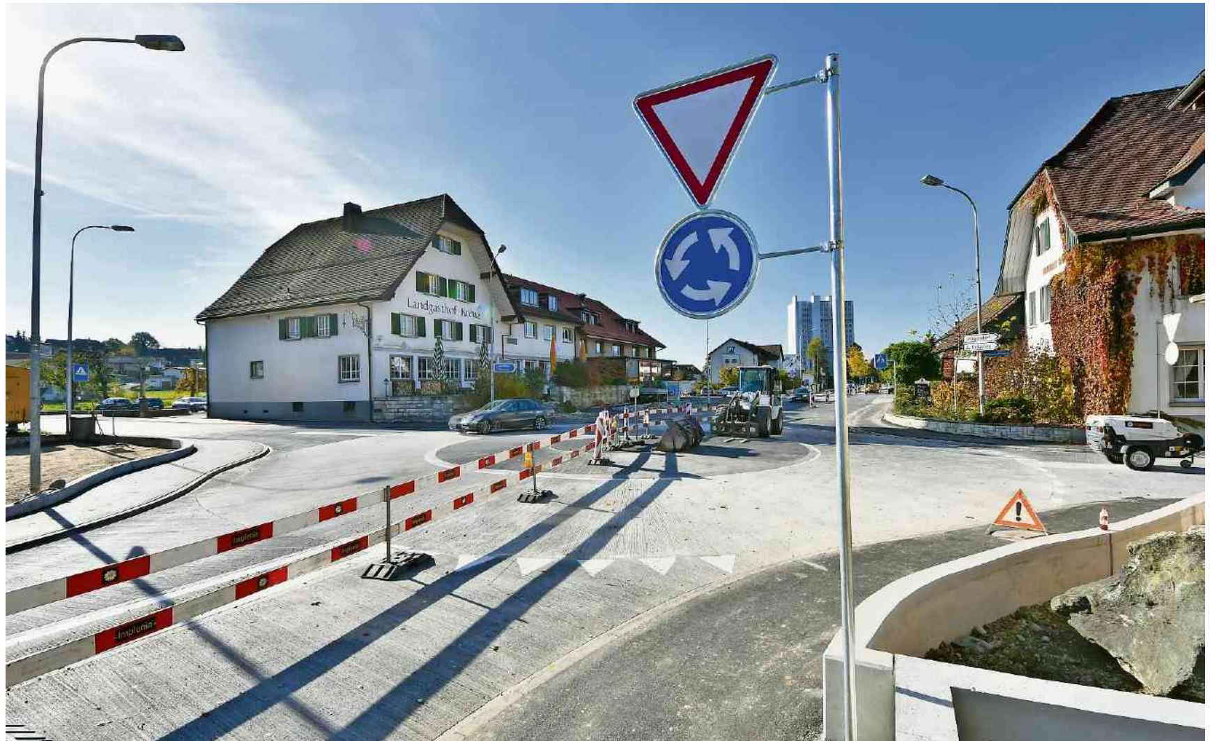
Der Kreisel in Kappel ist saniert: Ab heute Freitag gegen Mittag wird der Verkehr wieder im gewohnten Rahmen fließen.
